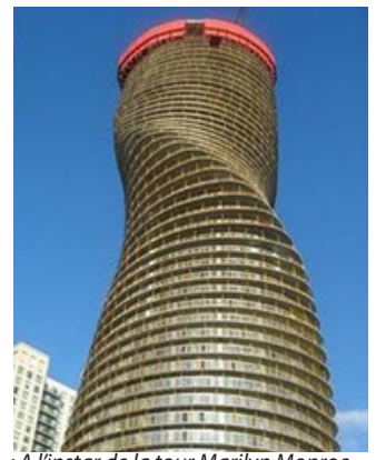
: A l'instar de la tour Marilyn Monroe, à Toronto, dont chaque étage est décalé en rotation, toutes les formes de tours sont aujourd'hui possibles.
