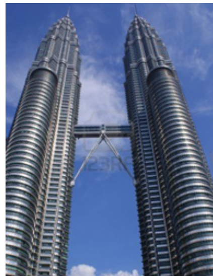
Pour la construction des tours Petronas, en Malaisie, il a fallu trouver la bonne formule de béton pour qu'il soit très résistant mais aussi pour qu'il puisse permettre une certaine flexibilité de l'ouvrage.
