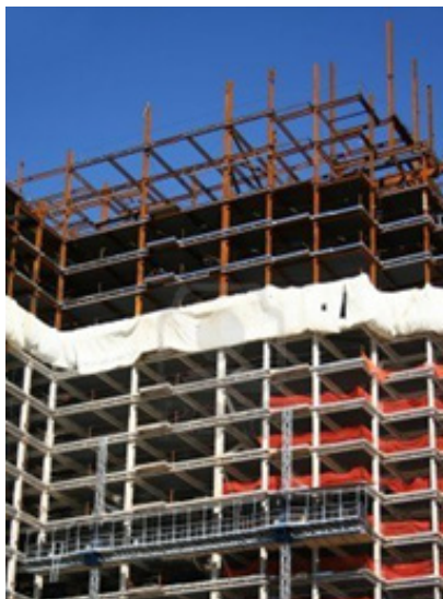
Construction d'un immeuble à ossature poutres-poteaux métallique.
