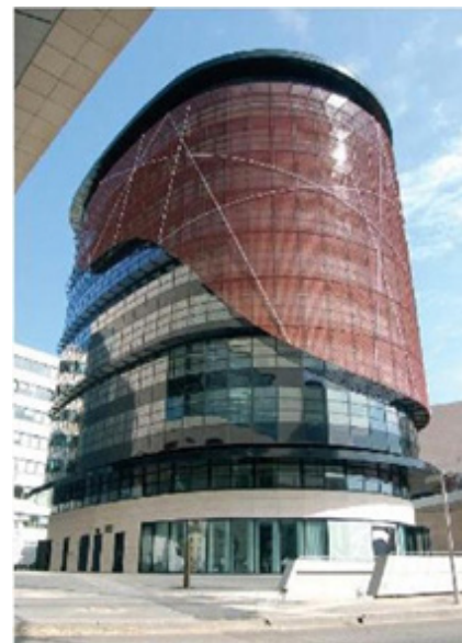
Tour Elithis à énergie positive grâce entre autre à une automatisation globale des équipements énergivores.
