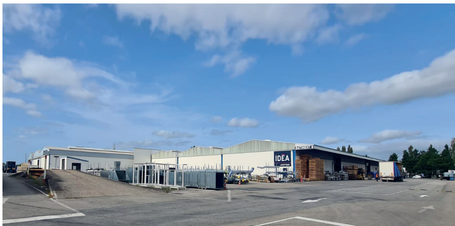
Figure 27 : Photo du bâtiment B section aéronautique, vue de l'extérieur
