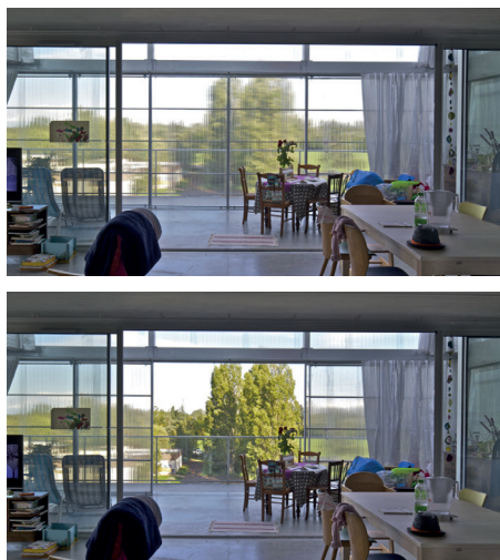
Figure 36. Photographies du projet de 96 logements à Chalon-sur-Saône de Lacaton et Vassal, montrant les différentes formes permises par jardins d'hiver (source : Lacaton & Vassal)
