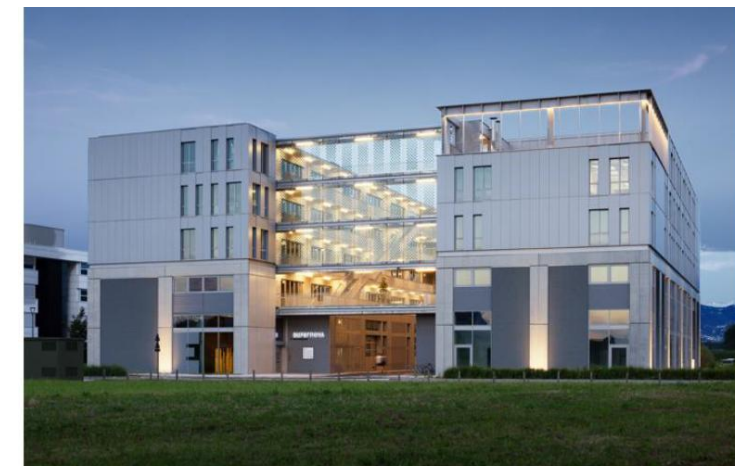
Immeuble de 6600 m 2 SDP construit sur 5 niveaux:
