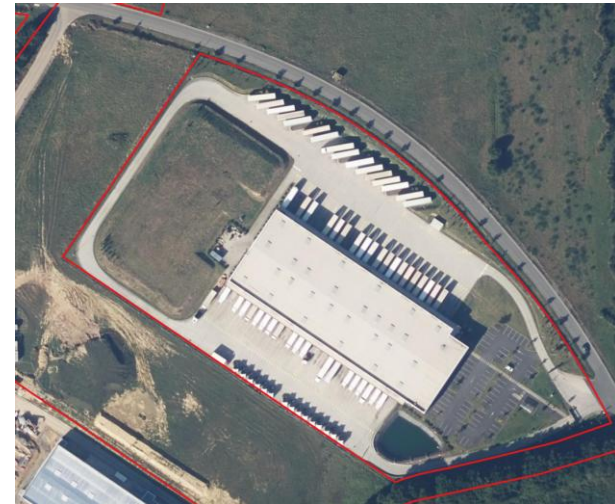
XPO logistics : 3 hectares de terrain, 5000 m 2 de bâti. CES de 0,15 et 85 emplois.
