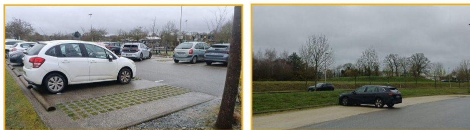
Figure 11. Photographies des places de parking Décathlon perméables déjà présentes
