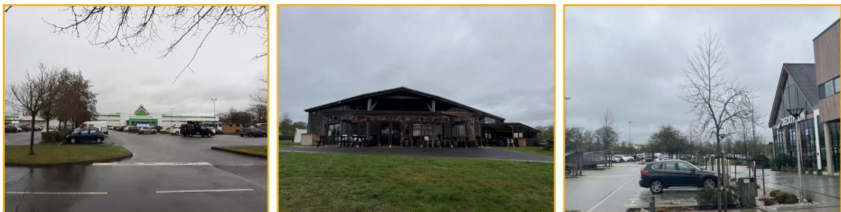
Figure 8. Photographies des façades extérieures des magasins
