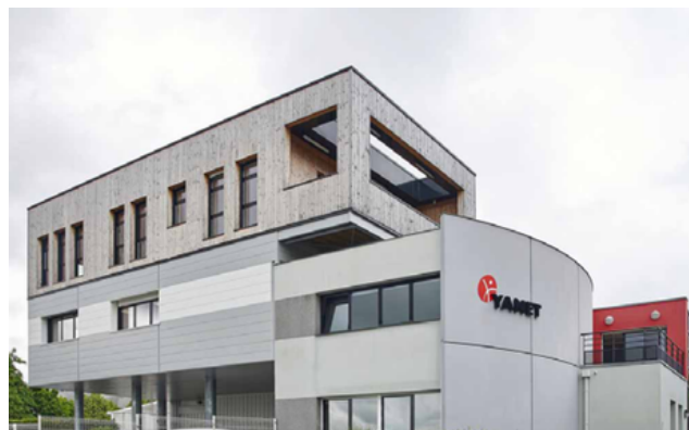
Figure 18 : Surélévation en bois d'une entreprise existante, Saint-Herblain (44)
