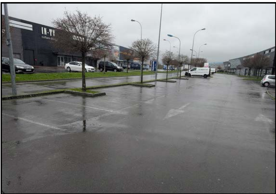
Intérieur parking de la zone économique
