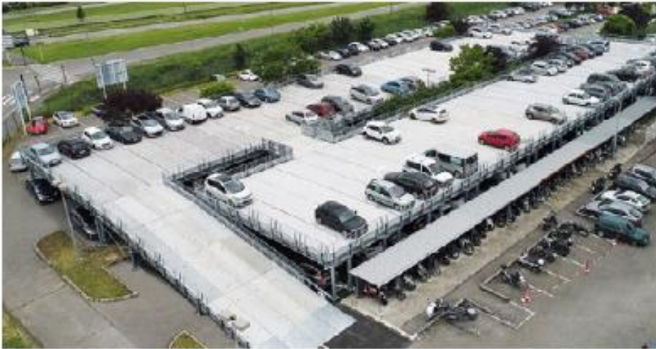
→ Système de parking modulable préfabriqué et démontable Solution Park'up, Nextensia
